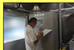
施設点検の様子
