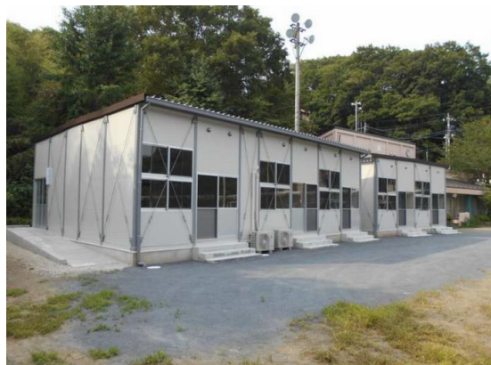
【仮設校舎全景】
