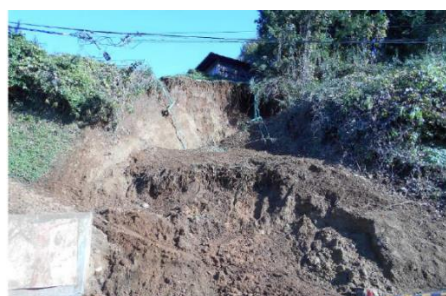
(進入路の法面)
