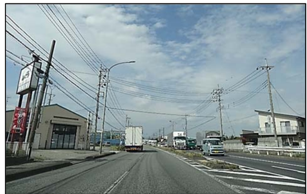
図 2-5 国道129号新宿小学校前交差点付近 (第一次緊急輸送道路及び重要物流道路に 指定された道路)
