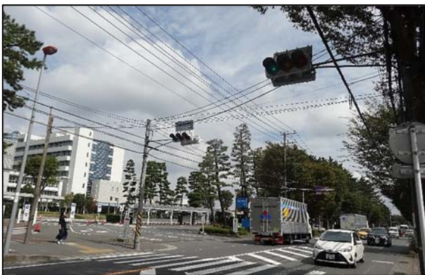
図 2-4 県道52号北里大学病院付近 (第一次緊急輸送道路に指定された 災害拠点病院付近の道路)
