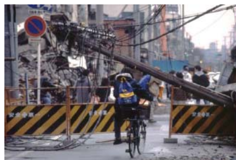
図5-2 道路を塞ぐ電柱（阪神・淡路大震災）
