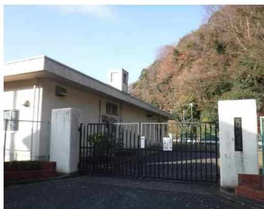
汚水ポンプ場（久所）
