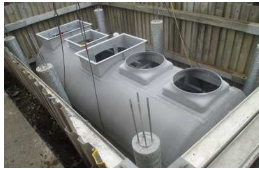
市設置高度処理型浄化槽*
