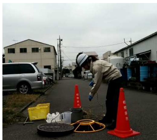
【事業場密集地での広域監視】
