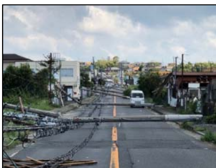
図 1-1 都市の防災性を妨げる電線・電柱
