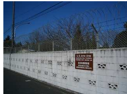
基地周辺を囲うコンクリートブロック塀
