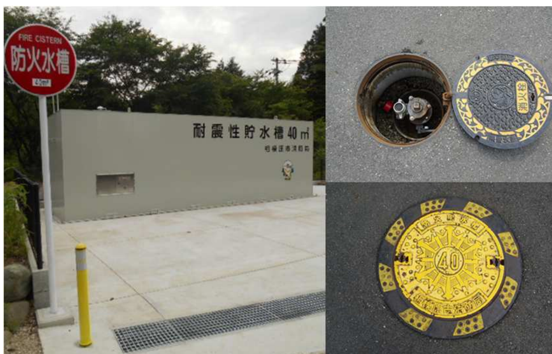
平成 30 年 12 月に整備した耐震性貯水槽（左） 消火栓（右上）・防火水槽の採水口（右下）
