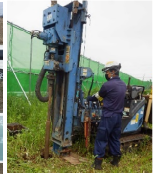
【ボーリング調査】
