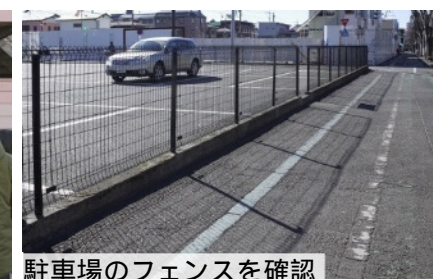
駐車場のフェンスを確認
