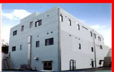
津久井列センター (し尿処理)
