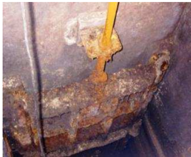
腐食が進行し開閉に支障 (自動除塵機(ガイトロー)の偏摩耗)
