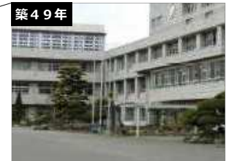
築49年 中野小学校 建築年度：S47-H23 延床面積：6,813㎡
