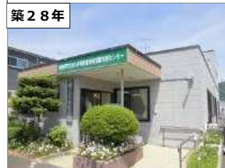
築28年 津久井障害者地域活動支援センター 建築年度：H5 延床面積：230㎡
