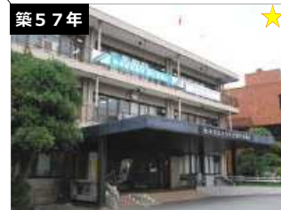
築57年 ★ 津久井総合事務所 建築年度：S39-H18 延床面積：2,335㎡
