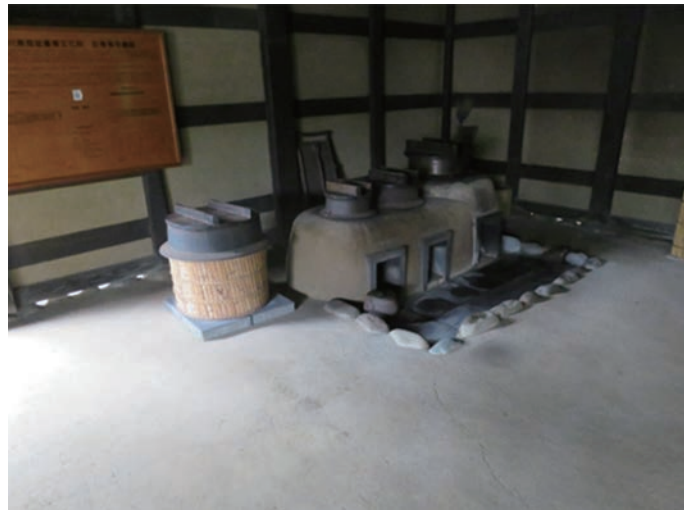
相模原市公民家園（相模川自然の村公園内）にある 神奈川県指定重要文化財旧青柳寺庫裡のカマドと土間
