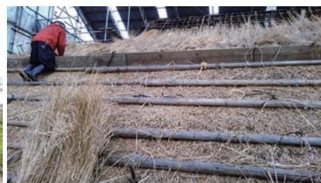
修繕中の屋根
