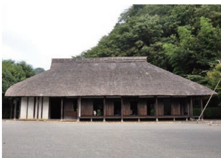
修繕前 建物正面
