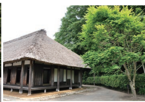
修繕前 建物東側
