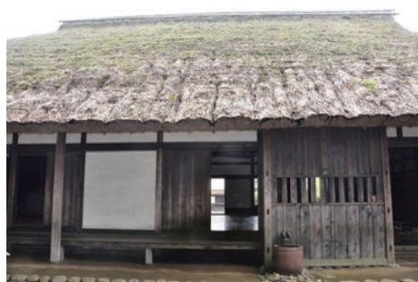
修繕前 建物裏側
