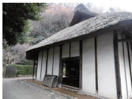
修繕前 建物西側
