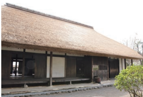
修繕後 建物裏側
