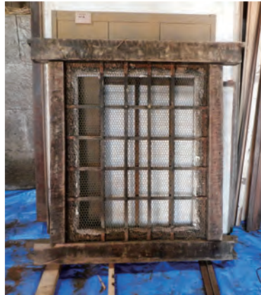
二階正面の建具 嵌め殺し鉄製格子組窓
