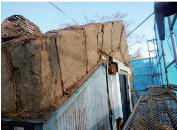
土蔵 鉢巻 下地板解体 南から
