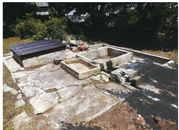
モルタル流し 南から
