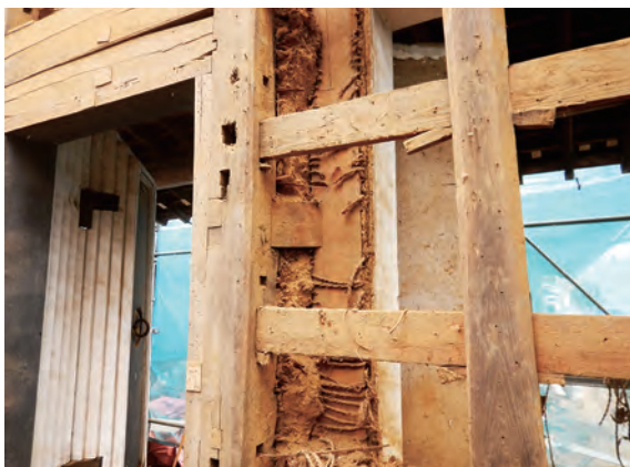
土蔵 一階扉 実柱腕木 西から
