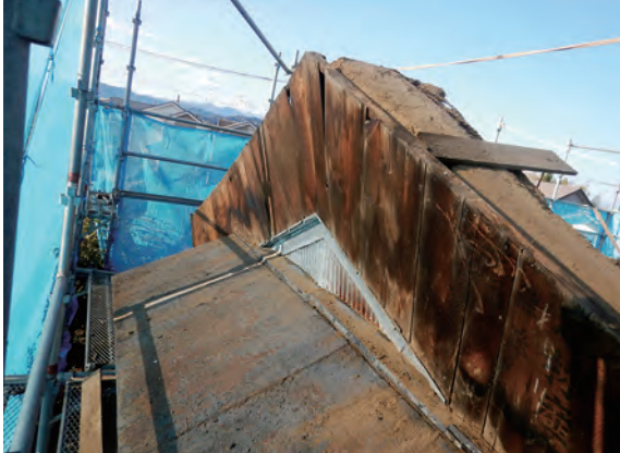
土蔵 鉢巻板金解体 下地板確認 北東から
