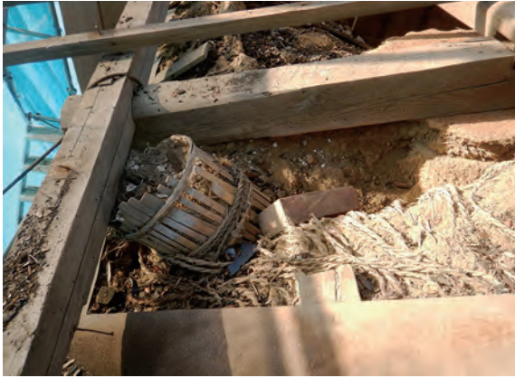
土蔵 登り梁と控えの束 南東から
