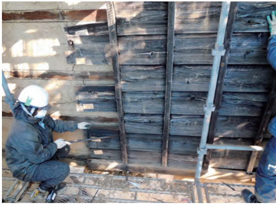
土蔵 南面 下見張り板解体 南西から
