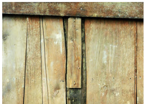
土蔵 西面柱妻部分 木札確認 南東から
