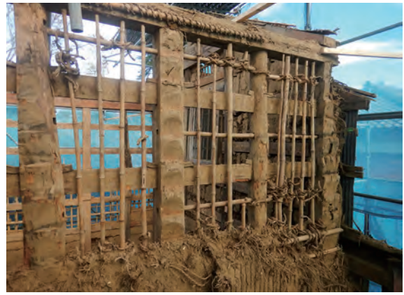
土蔵 南面 木舞下地 南西から
