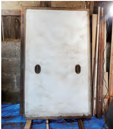
一階正面の建具 漆喰塗りの土引戸
