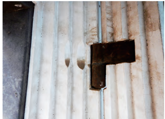
土蔵 一階扉 肘ガネ 南から
