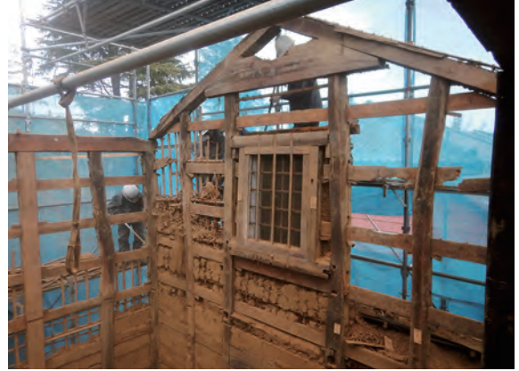
土蔵 二階扉実柱 西から
