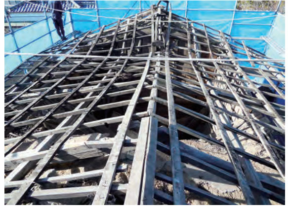
土蔵 置き屋根 波板板金解体 南東から
