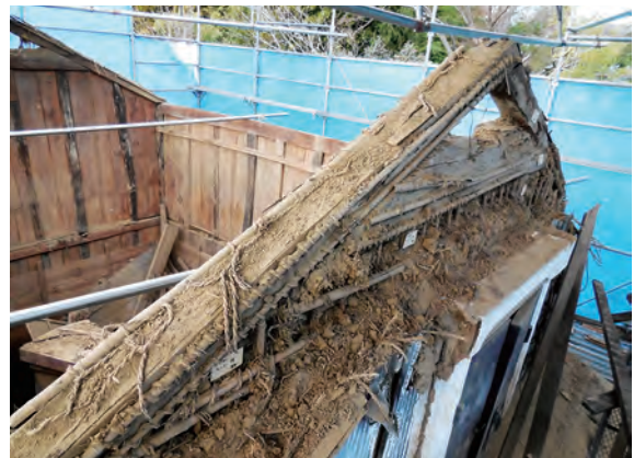
土蔵 鉢巻 土解体 南から
