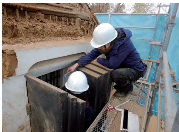
調査風景 土蔵 南から
