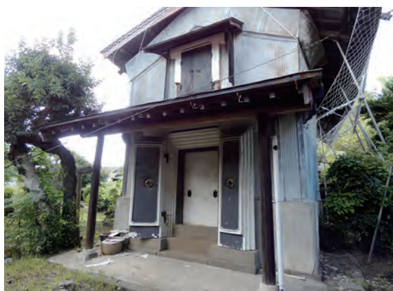
土蔵 解体前 東面 東から
