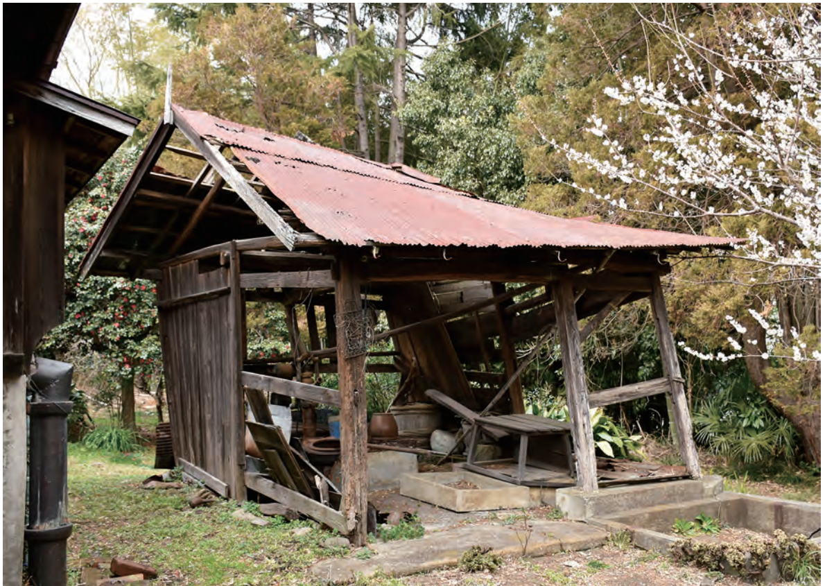
井戸上屋 解体前 東面・南面 南東から
