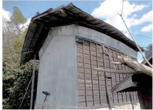
土蔵 西面 西から
