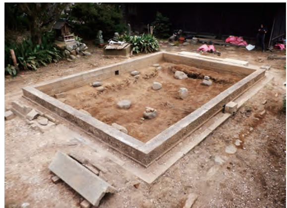
土蔵 基礎 西から
