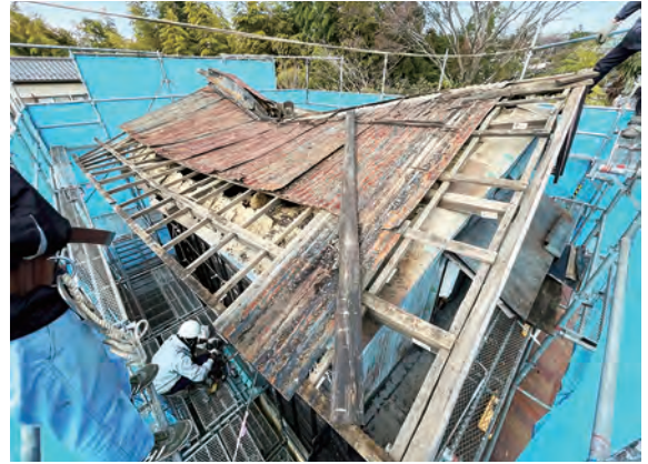
土蔵 置き屋根解体1 南から
