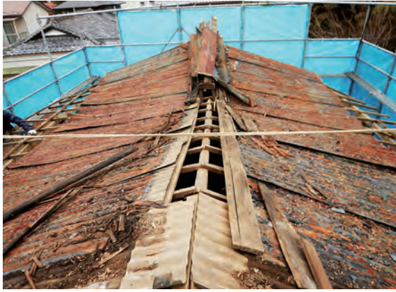
土蔵 置き屋根 箱棟下地材解体 南東から
