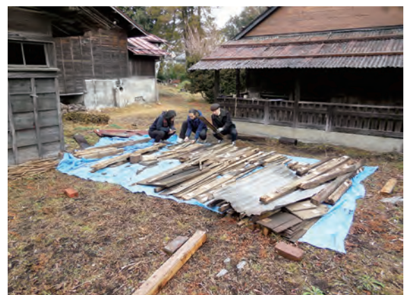
部材調査 南から
