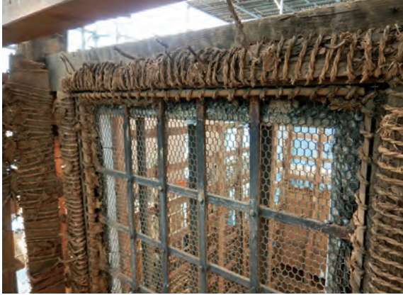
土蔵 二階扉 漆喰下地 東から
