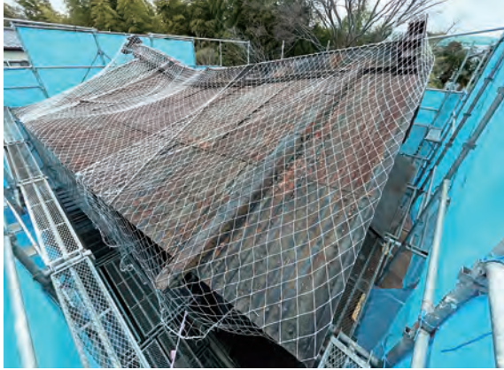
土蔵 置き屋根解体前 南から
