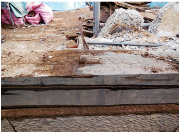
土蔵 土台繋ぎ 北西から
