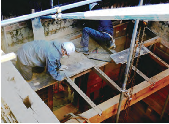
土蔵 二階床根太 北から
