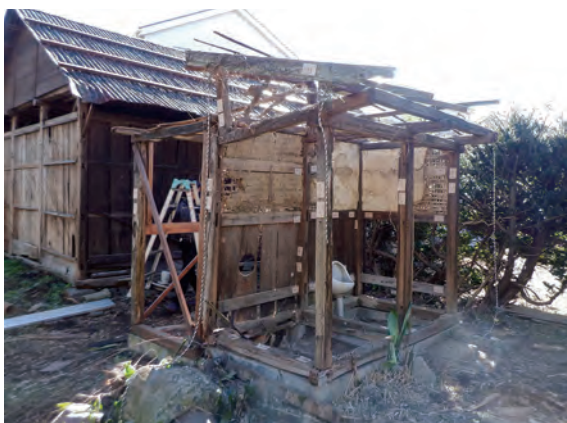
壁材撤去後 北から
