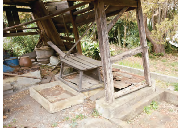
井戸上屋 内部 南東から 平成 25 年撮影
