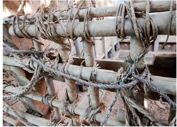
土蔵 南面 木舞下地 南から
