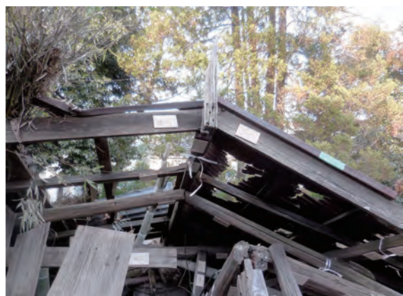
井戸上屋 外観 南西から
