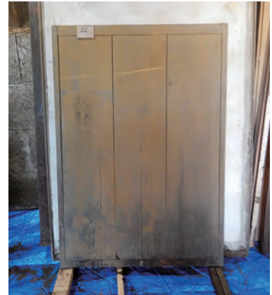
二階階段入口開口部 縦板張りの板戸
