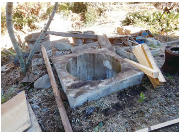
解体中の井戸 南西から
