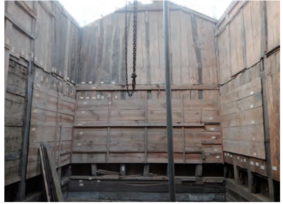
土蔵 内壁 壁板 南東から
