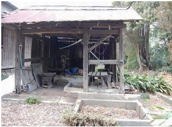
外観 南東から 平成 25 年撮影
