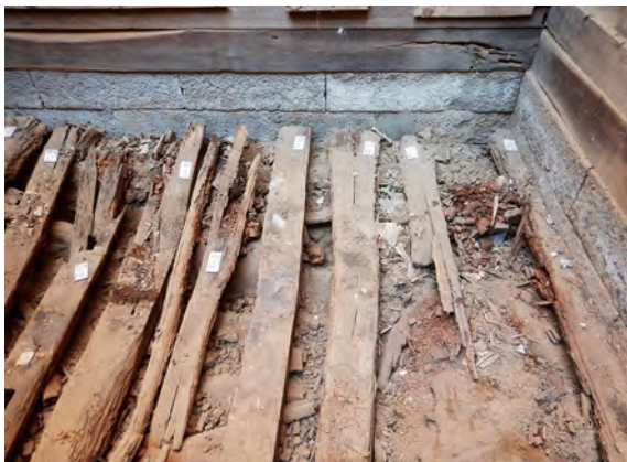
土蔵 一階床大引き 北東から
