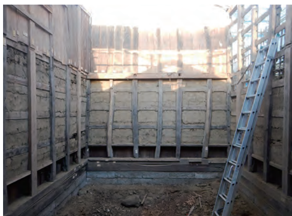
解体中の軸部 南東から
