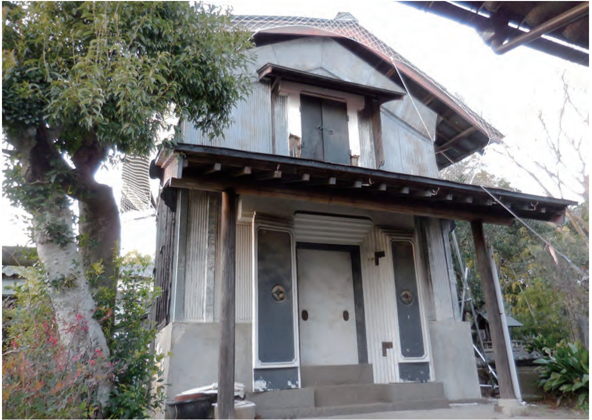
土蔵 解体前 東面 南から
