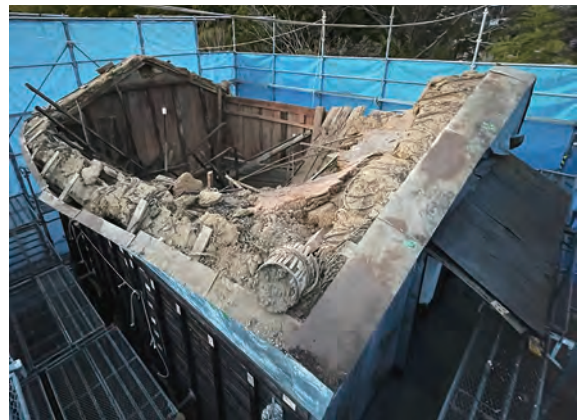
土蔵 置き屋根解体3 南から
