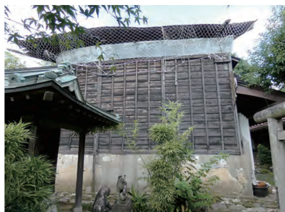
土蔵 解体前 南面 南西から
