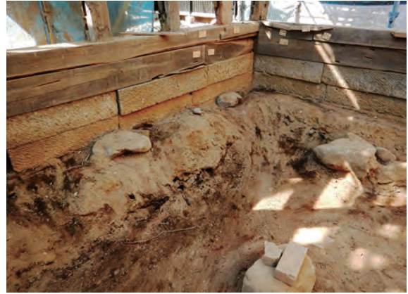
土蔵 土台 東から
