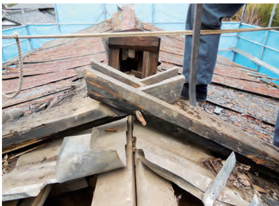
土蔵 箱棟内部木札確認 南東から
