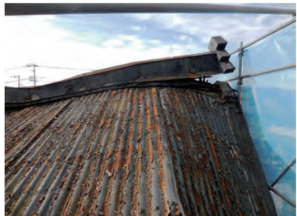
土蔵 置き屋根 解体前 北東から
