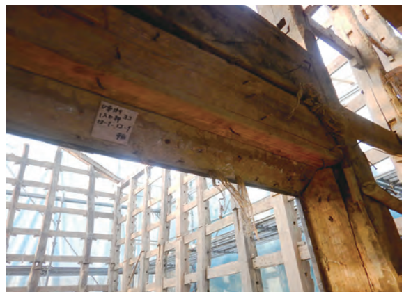
土蔵 一階扉 掛け子下地 南から
