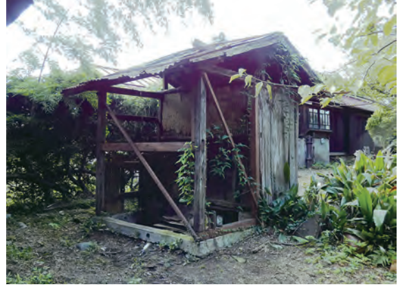
外便所 外観 東から
