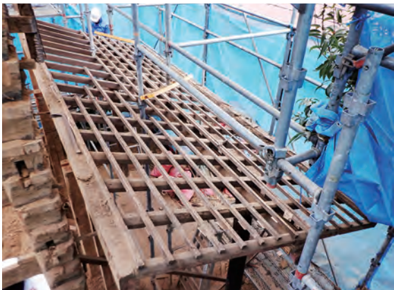
土蔵 下屋解体 南西から
