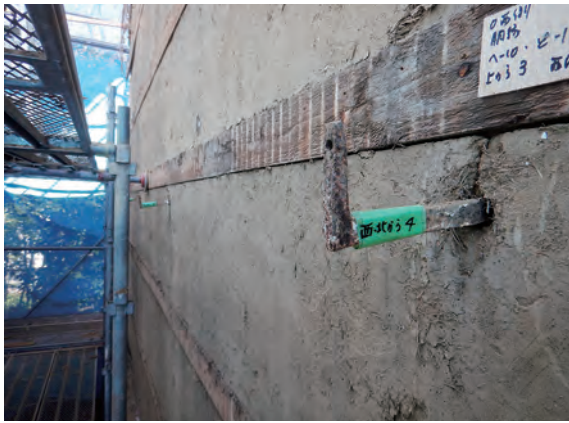
土蔵 西面 折れ釘 西から
