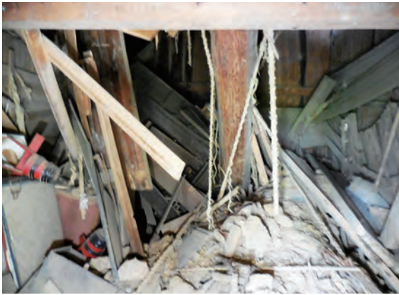
土蔵 内部一階 解体前 南東から
