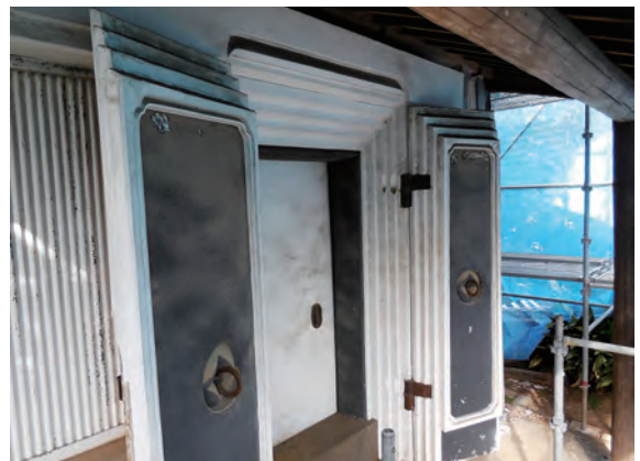
土蔵 一階扉 南から
