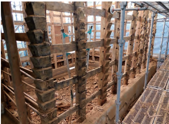
土蔵 北面 軸部 東から
