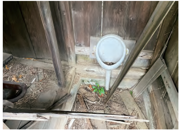
外便所 小便器 北西から
