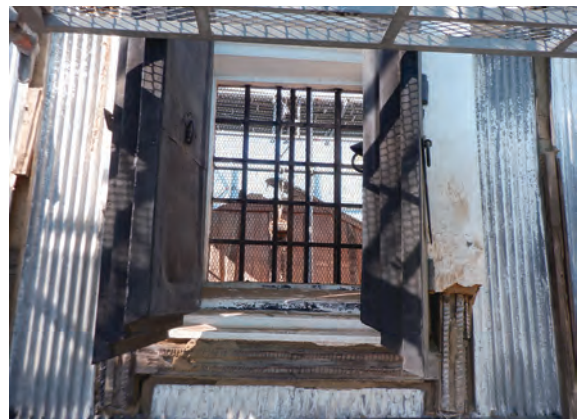
土蔵 二階扉 南東から
