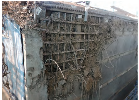
土蔵 北面 土壁解体 東から
