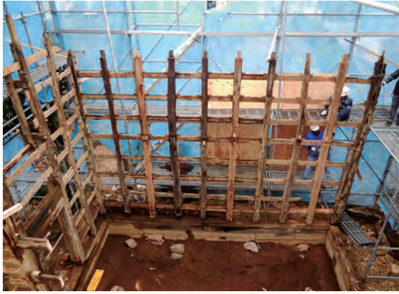
土蔵 南面 軸部 北東から
