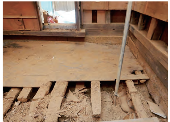
土蔵 一階床板 西から
