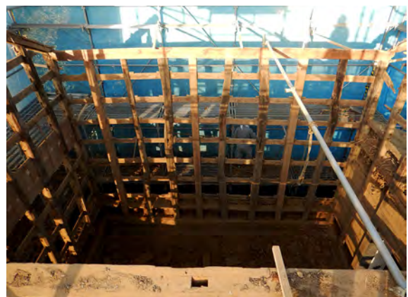
土蔵 北面 軸部 南西から
