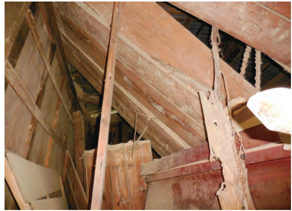
土蔵 内部二階 解体前 南東から
