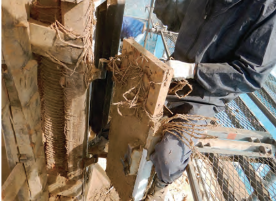
土蔵 二階扉解体 南から
