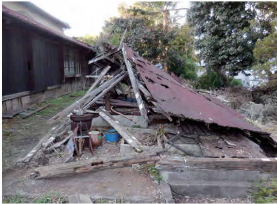
解体前の状況 南東から
