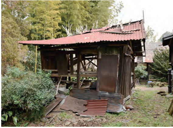
井戸上屋 外観 北西から 平成 25 年撮影
