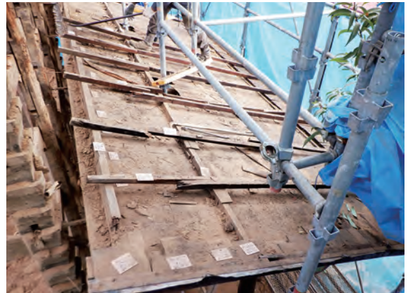
土蔵 下屋解体 南西から
