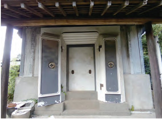
土蔵 東面 一階扉 南東から
