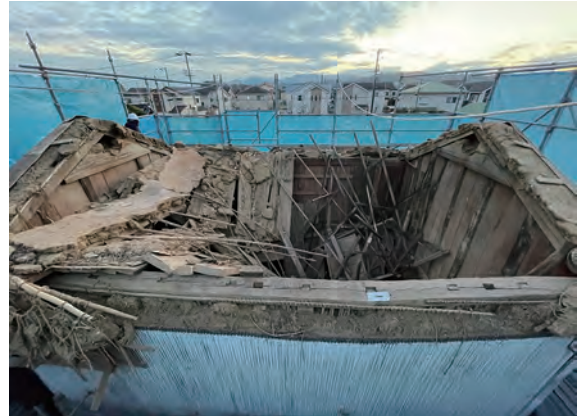
土蔵 置き屋根 垂木解体 北東から
