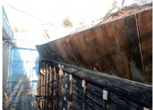
土蔵 鉢巻板金解体 下地板確認 南から
