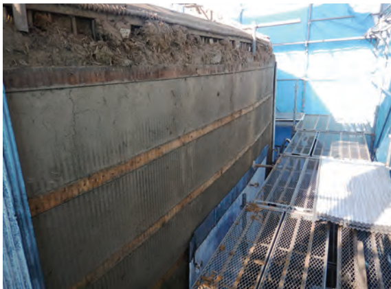
土蔵 北面 土壁 東から
