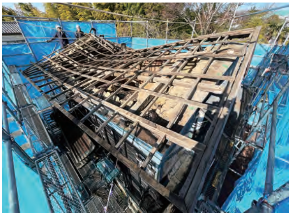
土蔵 置き屋根解体2 南から
