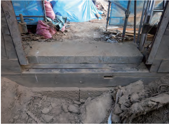
土蔵 一階扉 煙返し石 北西から
