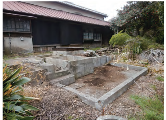
井戸上屋 モルタル流し 東から
