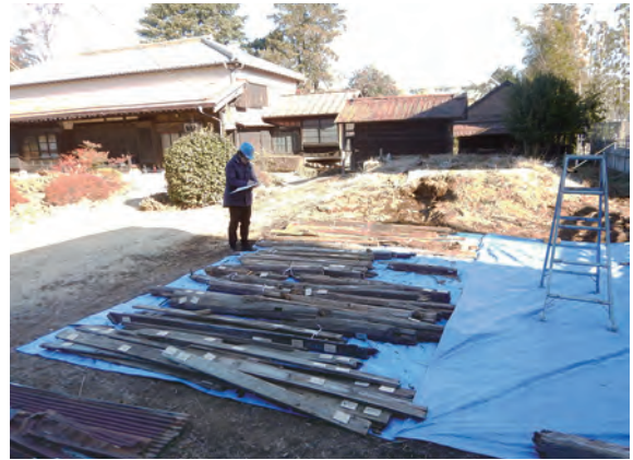
部材調査 南から
