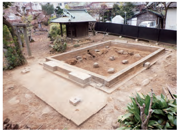
解体後の基礎 東から
