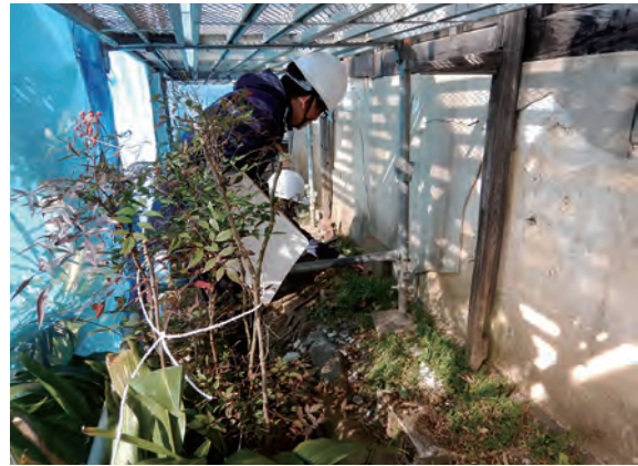
事前調査 土蔵 南東から
