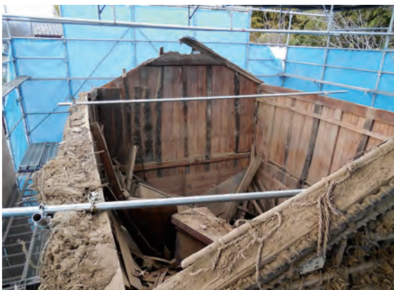
土蔵 西面柱妻部分 木札確認 南から
