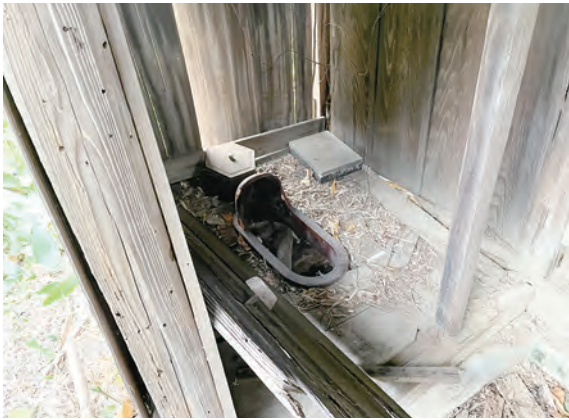
外便所 和式便器 南西から
