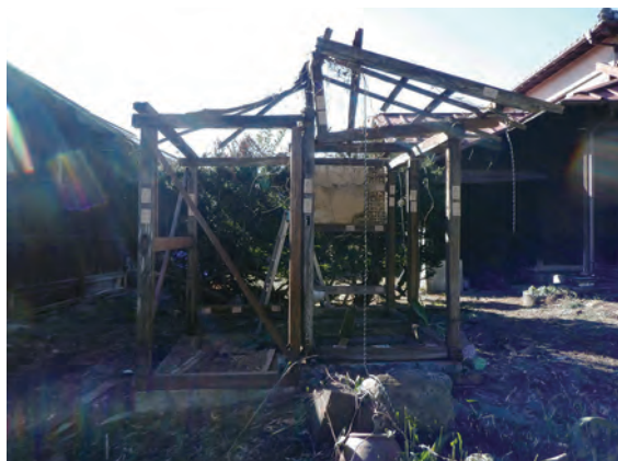
解体中の軸部 北東から
