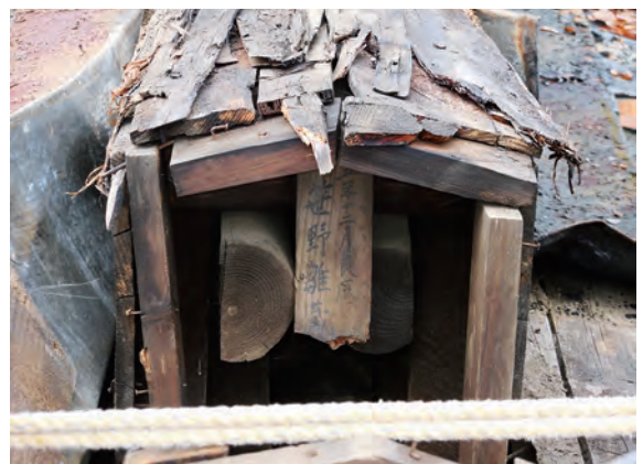
土蔵 箱棟内部木札確認 南東から
