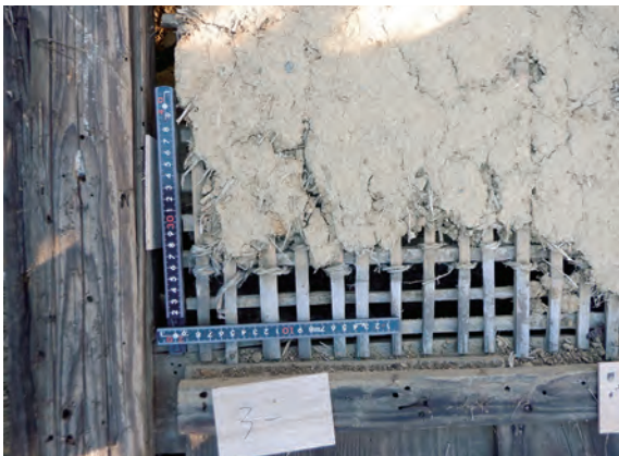
外便所 土壁 木舞下地 北西から
