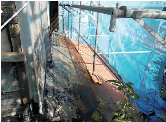
土蔵 下屋解体 南西から
