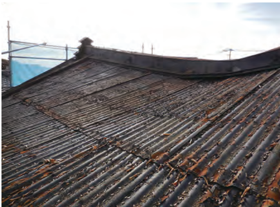
土蔵 置き屋根 解体前 北から
