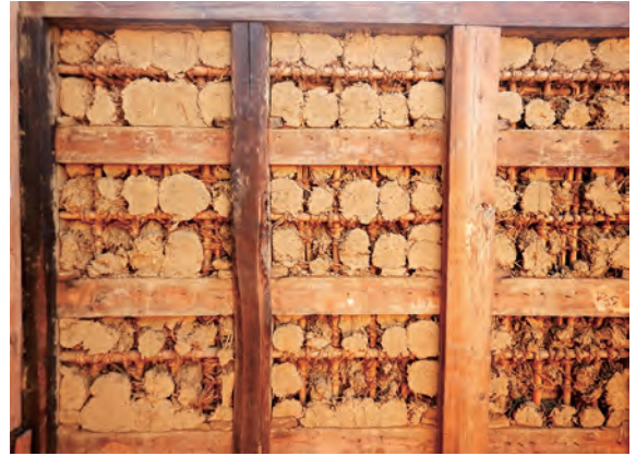
土蔵 二階内壁 壁板解体後 南西から
