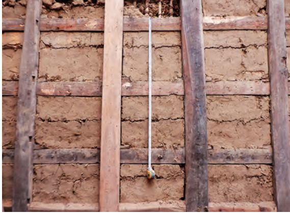
土蔵 一階内壁 壁板解体後 南西から
