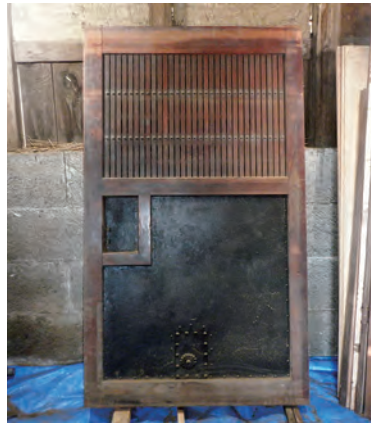
一階正面の建具 腰部を鉄張りとした格子戸
