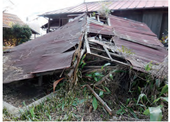
井戸上屋 屋根 北東から
