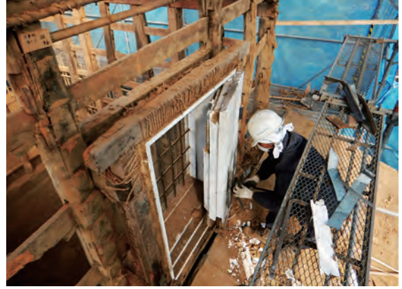
土蔵 二階扉解体 南から
