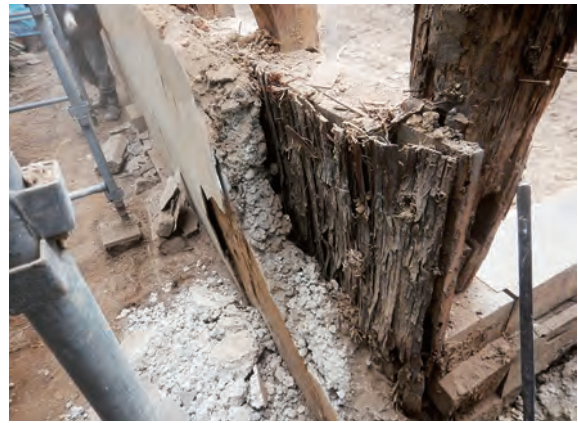
土蔵 腰部基壇 解体
