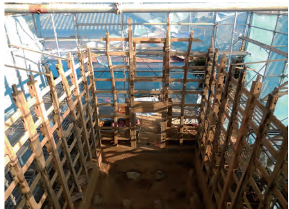
土蔵 東面 軸部 北西から
