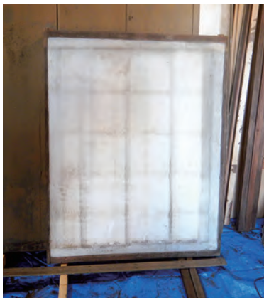
二階正面の建具 漆喰塗りの土引戸
