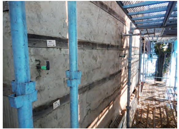
土蔵 南面 土壁 西から
