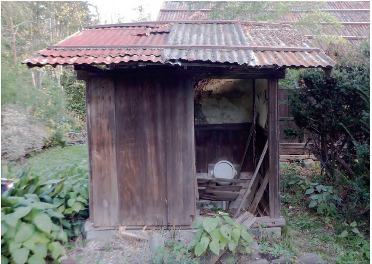
外便所 解体前 西面 北西から
