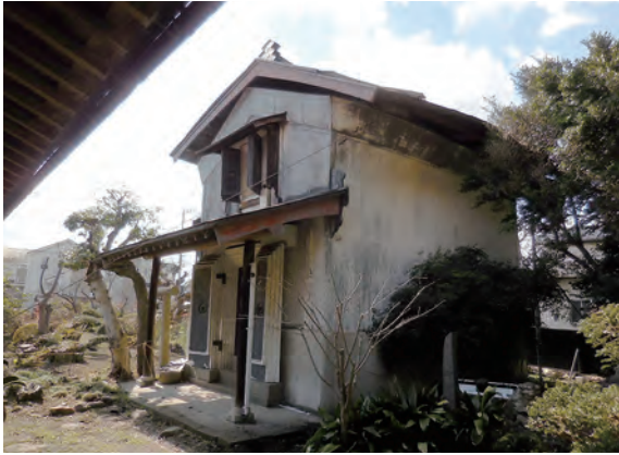
土蔵 北面 東から
