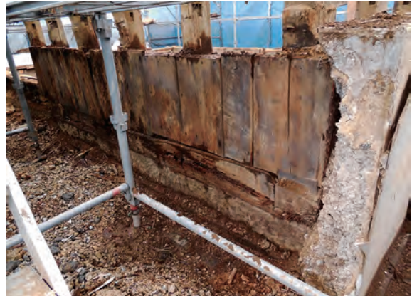
土蔵 腰巻下地板 北から
