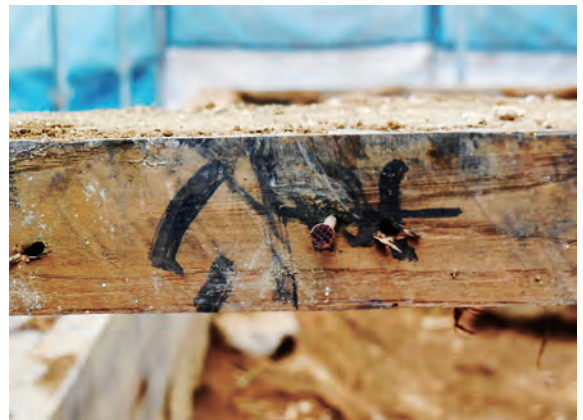
土蔵 腰巻柱根がらみ材 墨書き
