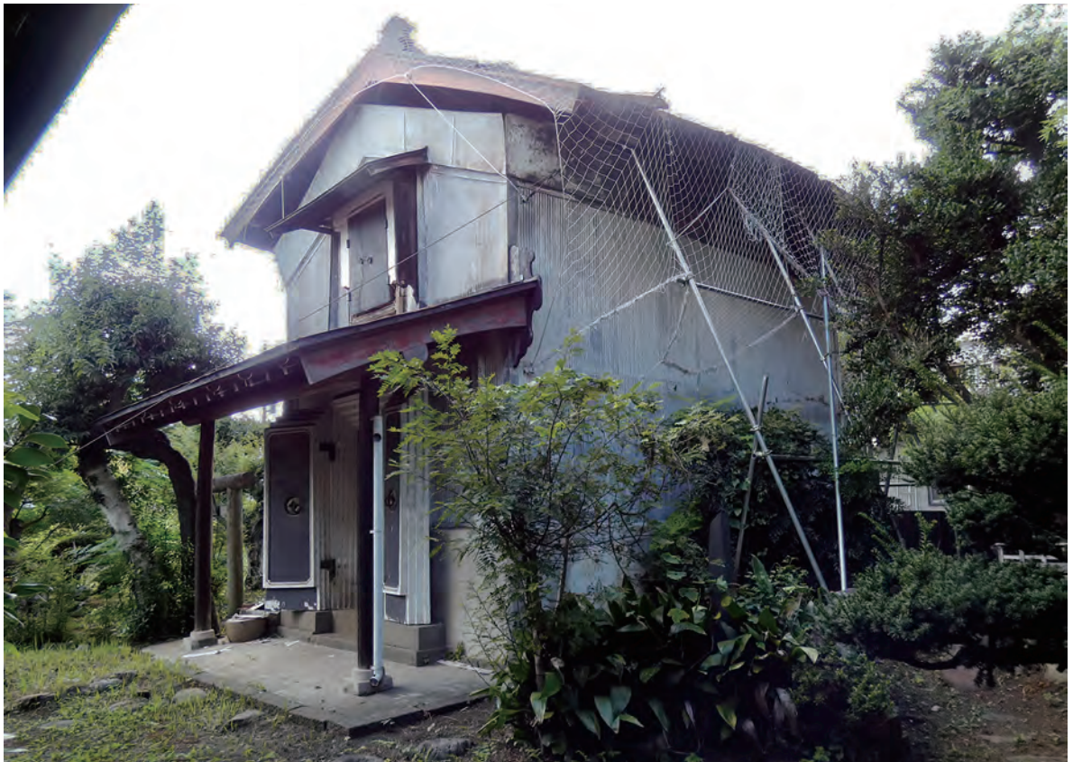
土蔵 解体前 東面・北面 東から
