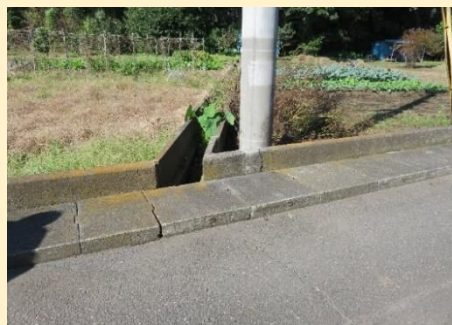
昔、利用した灌漑用水路と厚手の側溝蓋
