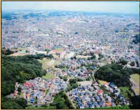
完成した若葉台から橋本方面を望む
