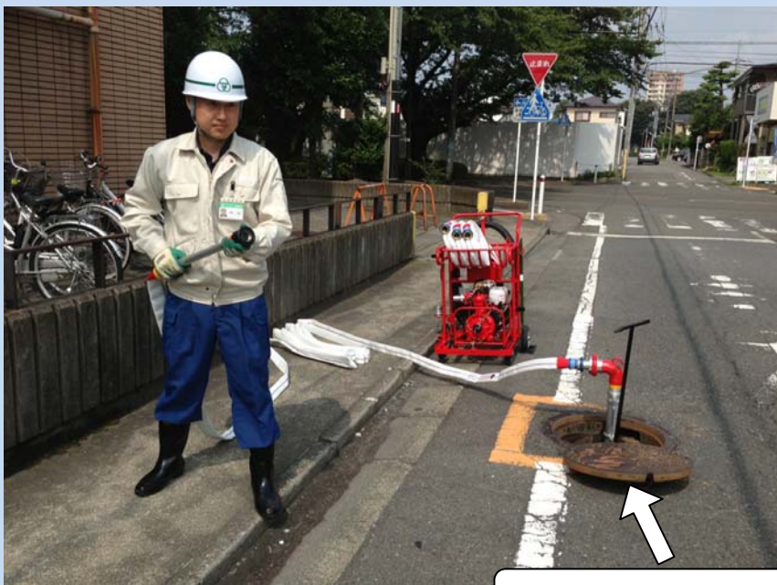
消火栓又は排水栓
