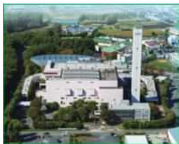
北清掃工場 〈緑区下九沢〉ごみ焼却・粗大ごみ破碎施設
