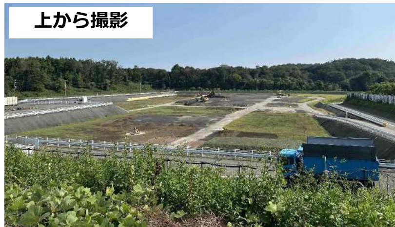
第2期整備地 (令和7年9月撮影)
