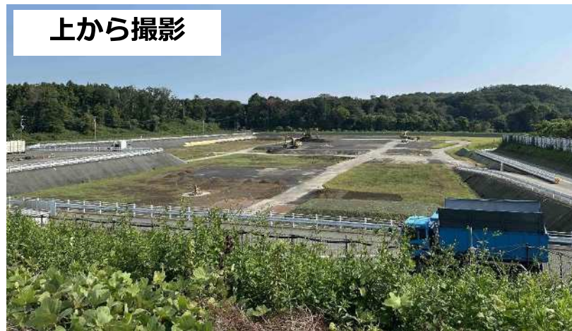
第2期整備地 (令和7年9月撮影)
