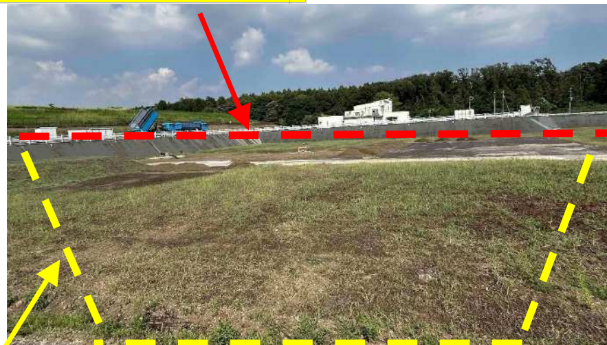
第2期整備地 (令和7年9月撮影)
