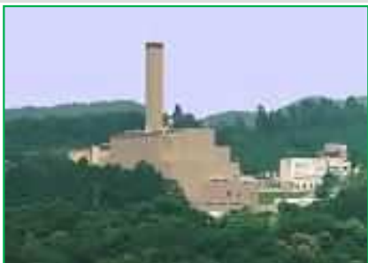
津久井クリーンセンター 〈緑区青山〉ごみ中継・し尿処理施設
