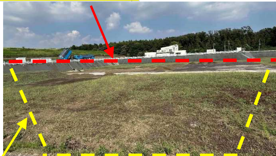
第2期整備地 (令和7年9月撮影)
