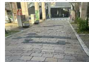
<路面(車道部)の状況>
