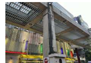
<アーケード柱の状況>
