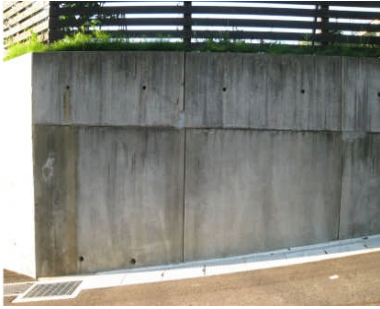
鉄筋コンクリート擁壁
