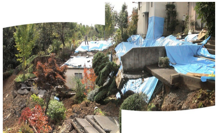
滑動崩落による被害状況（新潟県中越地震）
