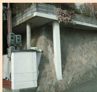
張出し床版付擁壁
