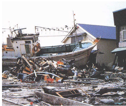
津波による被害状況 撮影：静岡県
