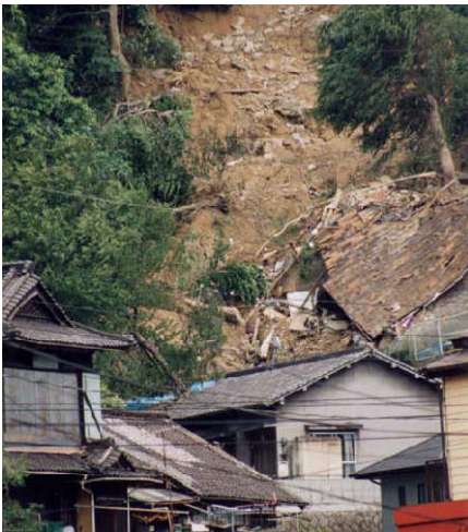
がけ崩れによる被害状況 出典：土砂災害ひろしまポータルサイト 「6.29豪雨災害写真集 がけ崩れ災害編」
