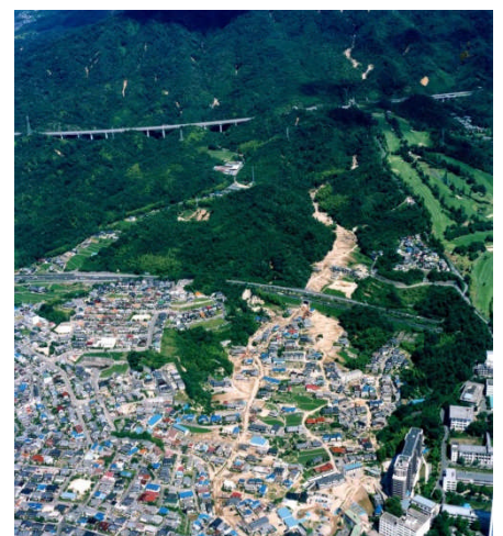
土石流による被害状況 出典：土砂災害ひろしまポータルサイト 「6.29豪雨災害写真集 土石流災害編」
