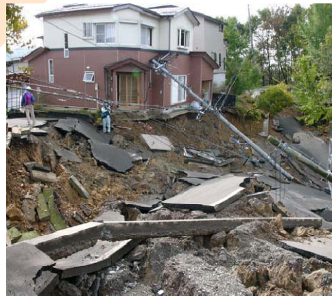
盛土の滑動崩落による宅地被害
