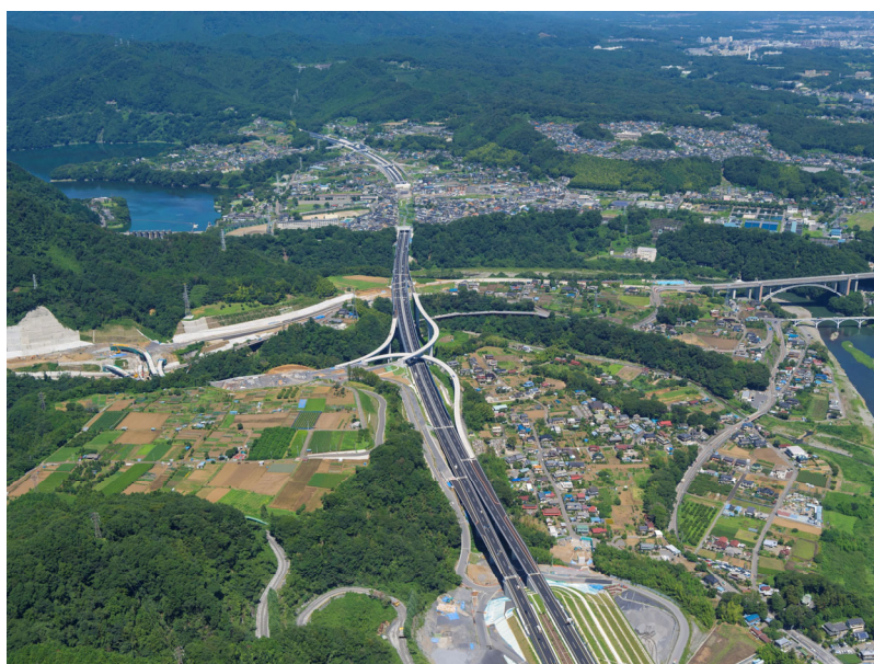
相模原インターチェンジ周辺
