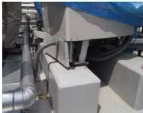
脚部損傷の例
