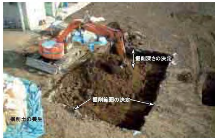
図 8-14 掘削除去の概況写真
