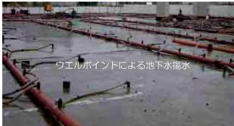
図 8-12 地下水揚水の概況写真
