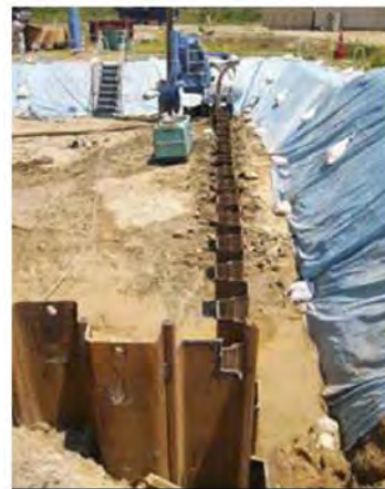
図 8-20 遮水壁（鋼矢板）の打設状況
