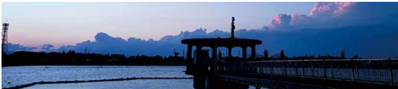
「相模原沈殿池」 帰り道
