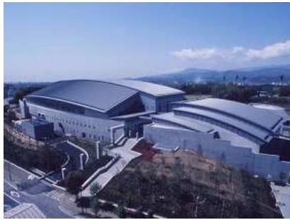
周辺環境に配慮し高さを抑えたさがみはらグリーンプール
