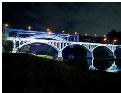
橋りょうのライトアップ（小倉橋）
