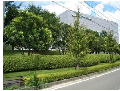
外周部を緑化した工場
