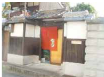
エントランスの門
