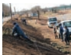
堤防へ植栽する様子
