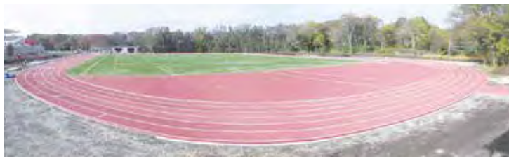
工事中の相模原ギオンフィールド
