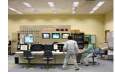
津久井郡ごみ処理施設
