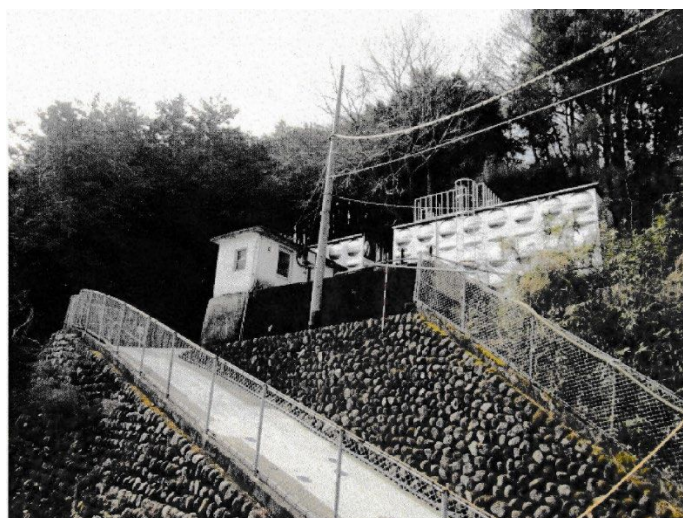
図表 15-3 葛原配水池
