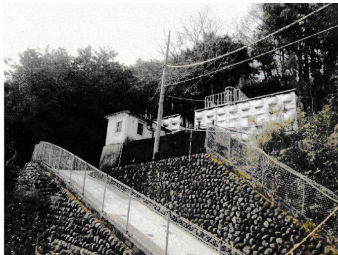
図表 15-25 葛原配水池
