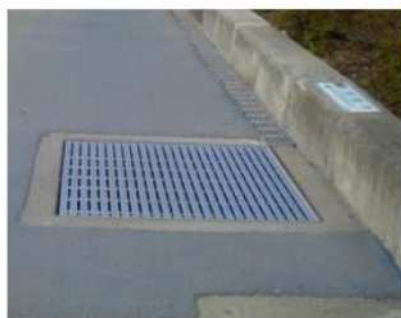
図-8 グレーティング蓋の格子間隔を狭めた事例(左) 及びマンホール蓋をすべり止め加工した事例(右)
