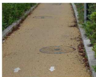
図-8 グレーティング蓋の格子間隔を狭めた事例(左) 及びマンホール蓋をすべり止め加工した事例(右)
