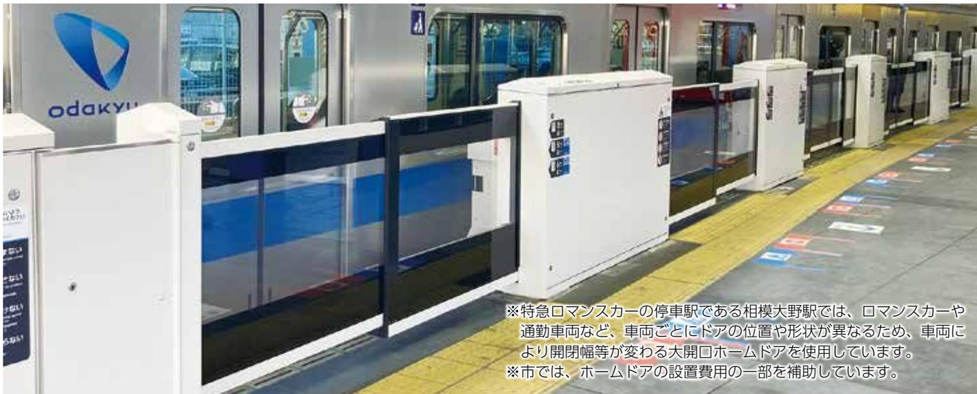
※特急ロマンスカーの停車駅である相模大野駅では、ロマンスカーや通勤車両など、車両ごとにドアの位置や形状が異なるため、車両により開閉幅等が変わる大開口ホームドアを使用しています。
