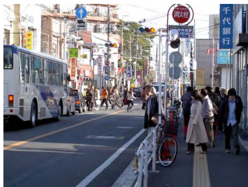
【県道町田厚木の様子（施行中）】
