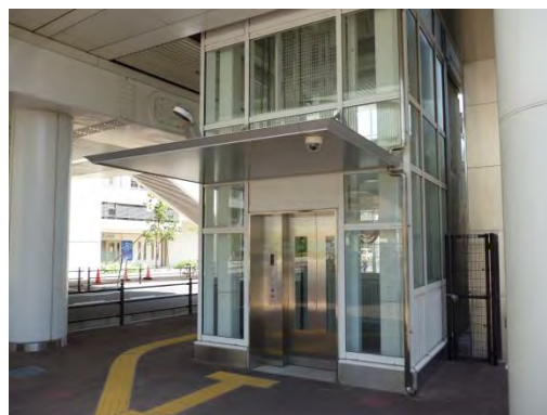
【施行区域内エレベーターの様子】
