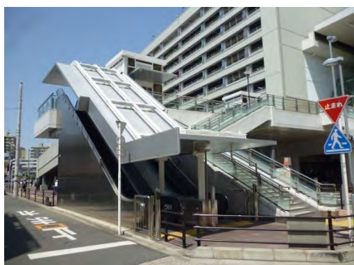
【施行区域内エスカレーターの様子】
