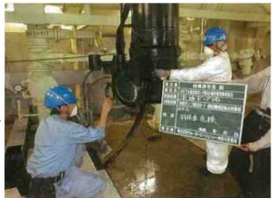
ポンプ設備の点検状況
