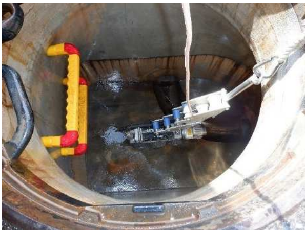
管きよの点検・調査（テレビカメラ調査）
