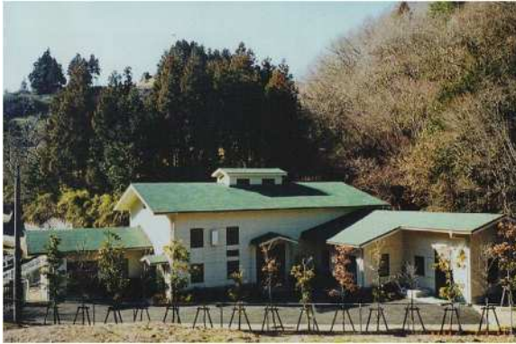
大久和排水処理施設（外観）
