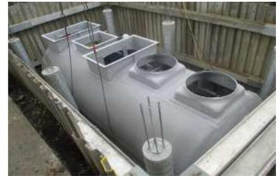
市設置高度処理型浄化槽
