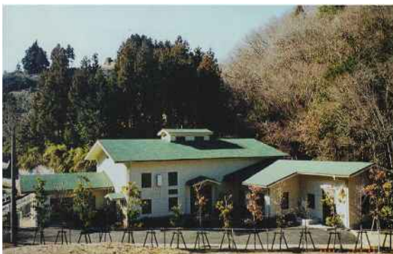
農業集落排水処理施設 (大久和排水処理施設)
