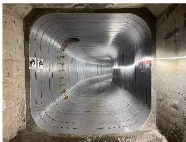
耐震化工事（実施後）
