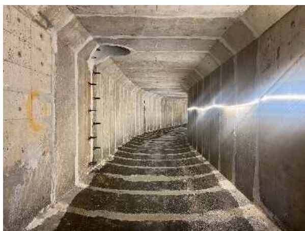
耐震化工事（実施前）
