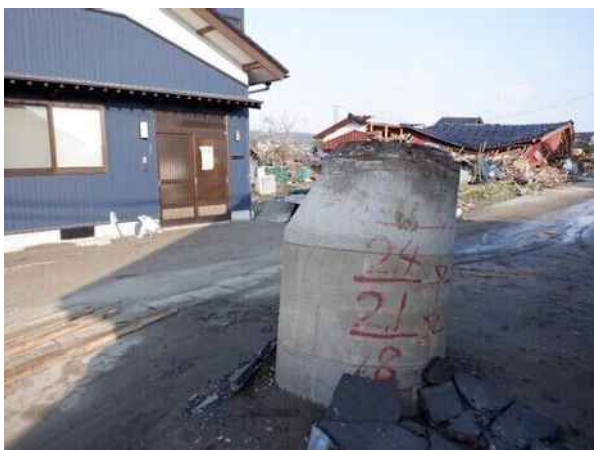
能登半島地震の影響による下水道施設の被災状況（石川県珠洲市）
