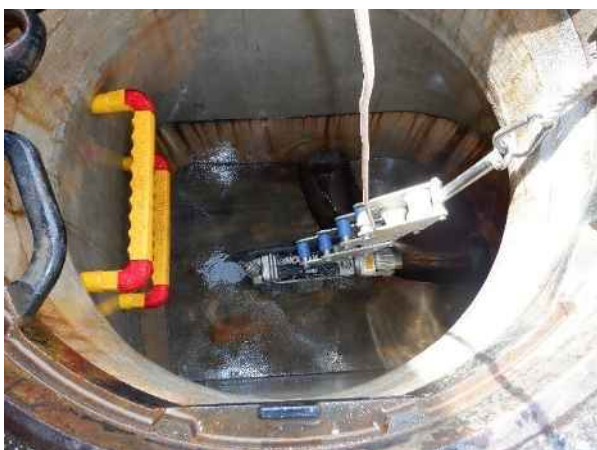
管きよの調査（テレビカメラ調査）
