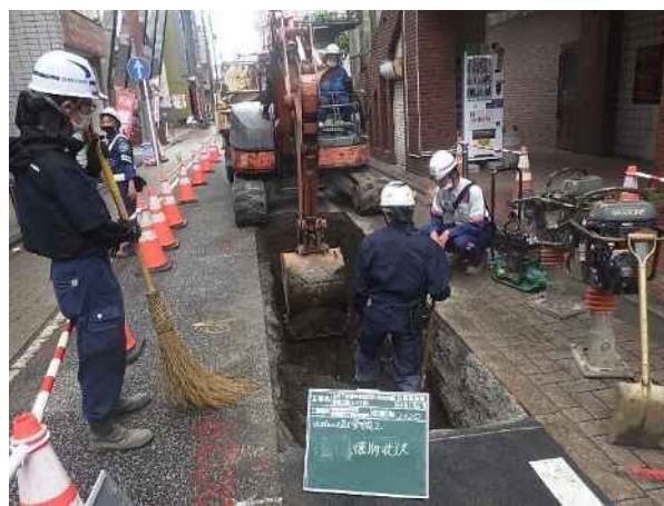
合流改善事業の施工状況
