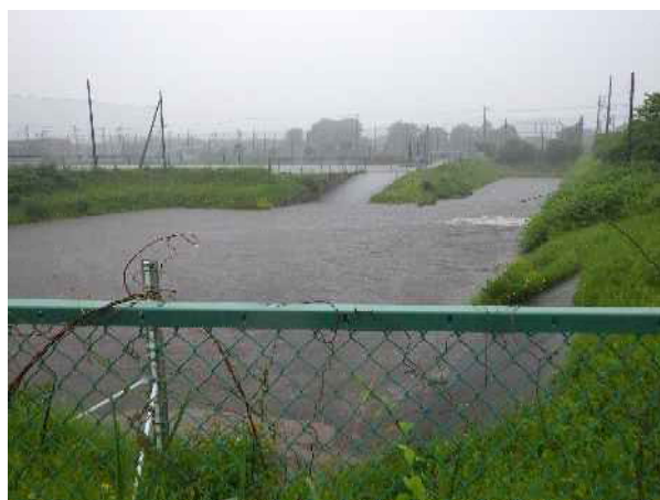
大雨時の雨水調整池貯留状況（相模原市）
