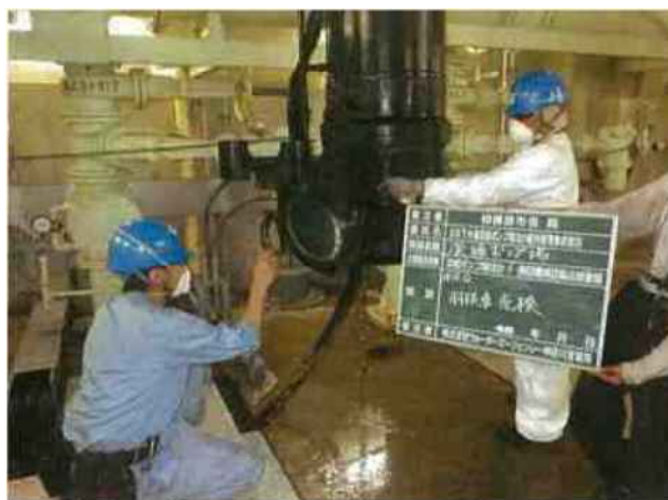
ポンプ設備の点検状況
