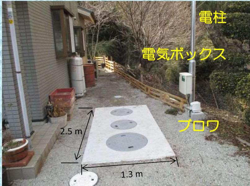
高度処理型浄化槽は通常の浄化槽では取り除くことができない窒素やリンを除去する浄化槽です。
