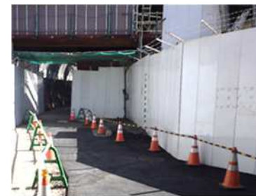
仮囲い設置例
