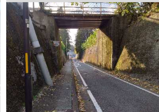
④座間3号橋(現況)
