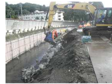
基地内からの施工例
