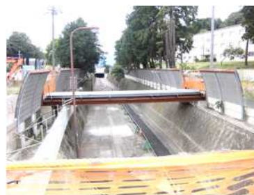
仮配管施工例
