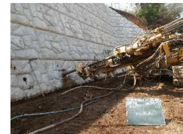
擁壁施工例②
