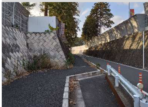
②掘割未整備区間(現況)
