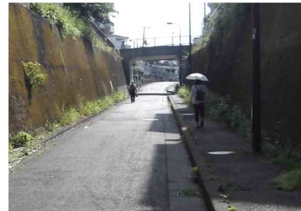
＜工事前＞ 中原陸橋
