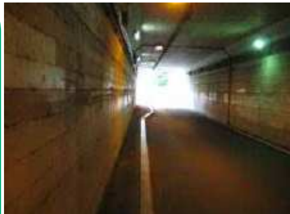
＜工事前＞ トンネル
