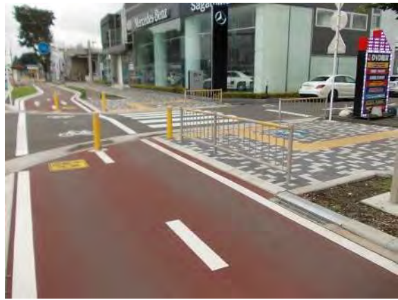
図 5.8 防護柵の設置イメージ
