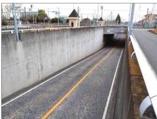
橋本小山ふれあい立体(西側)
