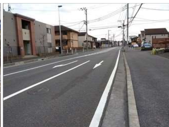
津久井広域道路・国道413号方面
