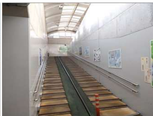
立体交差内部 (北側)
