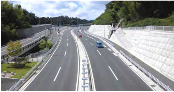
新小倉橋～市道沼荒久根小屋金原
