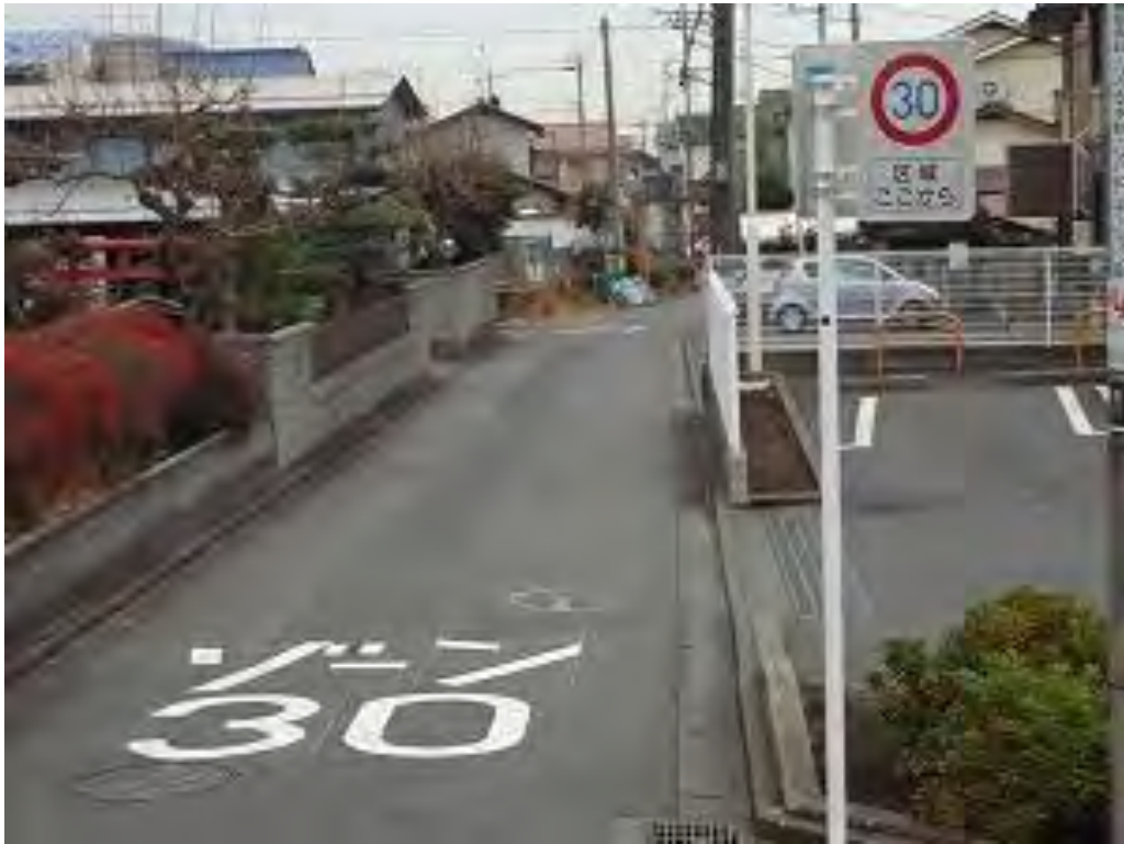
市道（区画道路）
