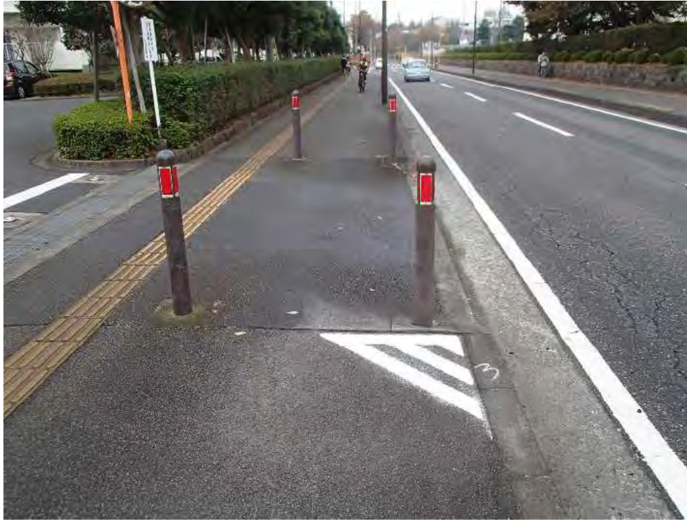
すりつけ部の段差の視認性向上対策
