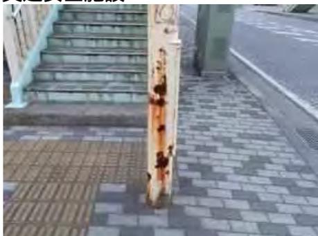
道路照明灯支柱下部の塗装劣化、さび
