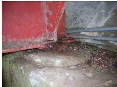
鋼支承のさび、しゅう座モルタルのひび割れ
