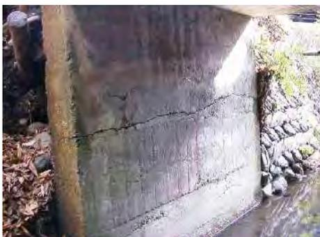
橋台前面の水平方向のひび割れ
