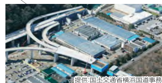
■さがみ縦貫道路 首都圏の一番外側に位置する環状道路である首都圏中央連絡自動車道の一部として整備が進んでいます。都市間の連携強化、産業の発展への効果が期待されます。
