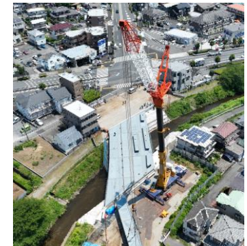
(都) 宮上横山線 橋梁工事
