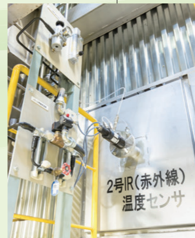
IRセンサ (自動燃焼制御装置) IR Sensor (Automatic control device)
